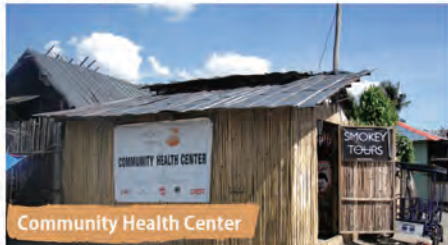
Community Health Center スモークーツアーズが建てたヘルスセンター。水や薬を提供。 A Community Health Center built by the Smokey Tours.
