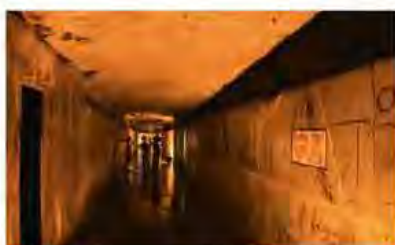
コンクリートで固められた側壁。天井はアドービス
