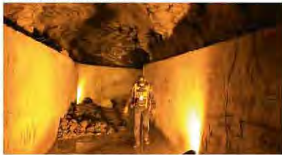
天井は部分的に落盤している。
