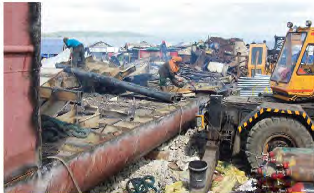
漁船の解体作業
