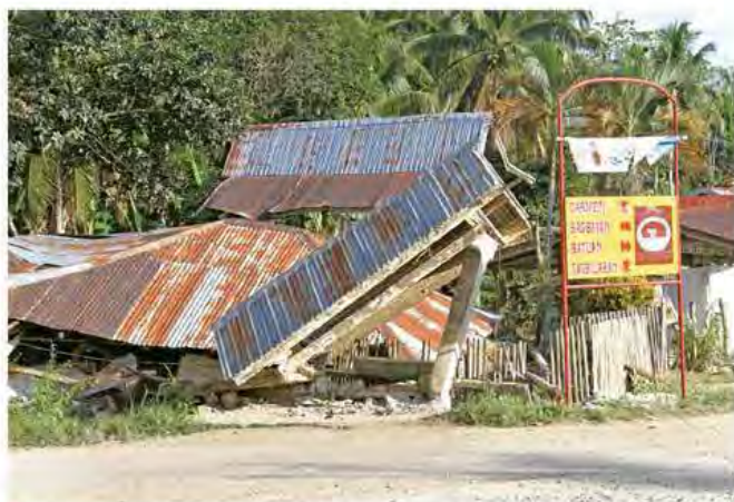
▲ ボホール地震で倒壊したバス停と民家（サグバヤン町の交差点付近）
