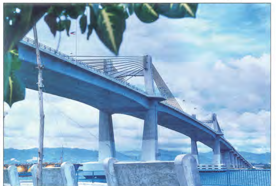
第2マクタン橋（マルセロ・フェルナン橋）は日本の円借款により1999年10月に竣工。工事を担当したのは鹿島建設。工期に11か月の遅れが出たがこれは事業内容の変更によるもので実際の工期はほぼ予定通りだったという。さすが日本。第3橋は香港の投資会社が母体で2017年に着工したようだが果たして2020年竣工という工期で完成に漕ぎつづけるのか？そこに第4橋の計画？もしまた日本の円借款で話が進めば竣工は第4橋が先なんて逆転現象もあり得るかも？
