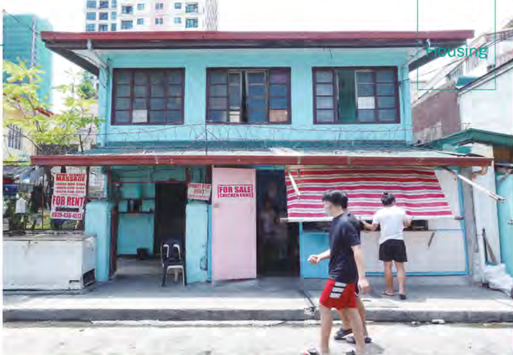
コンパウンドの母屋。向って左側に中庭へ向かう入り口がある。
