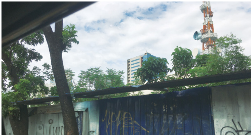
伐採が進む IT パーク。インターナショナルスクールの跡地の雑木林が伐採され、新たにビルの建設が予定されている。
