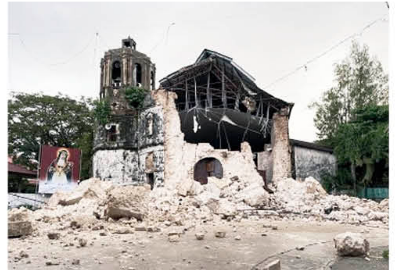
地震で倒壊したセブ島北部ダアンバンタヤン町の教会(写真提供: サンタロサ・デリマ大司教区教会)
